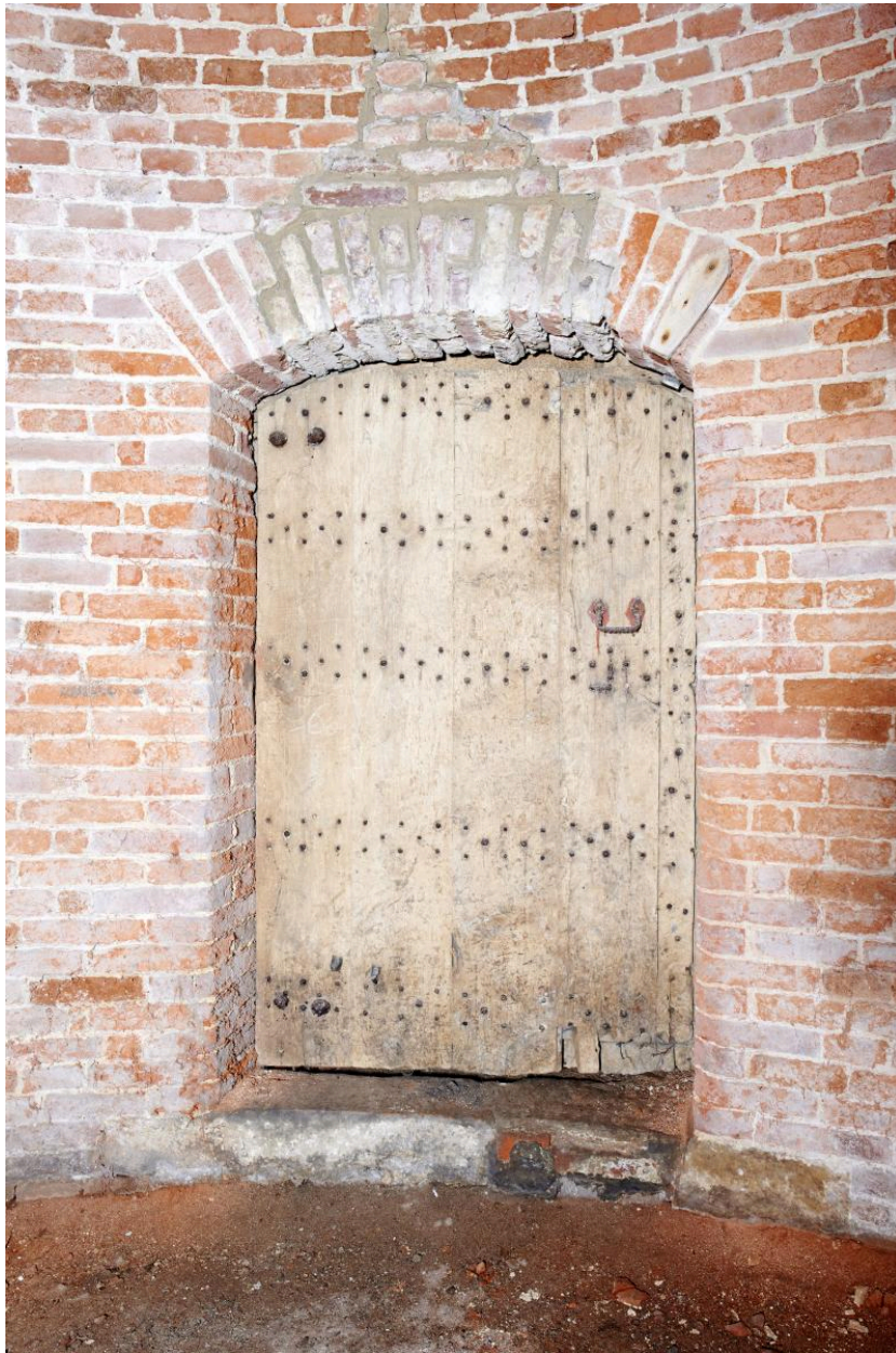
Niveau inférieur. Porte d'accès. Vue intérieure (présence de xylographies).
