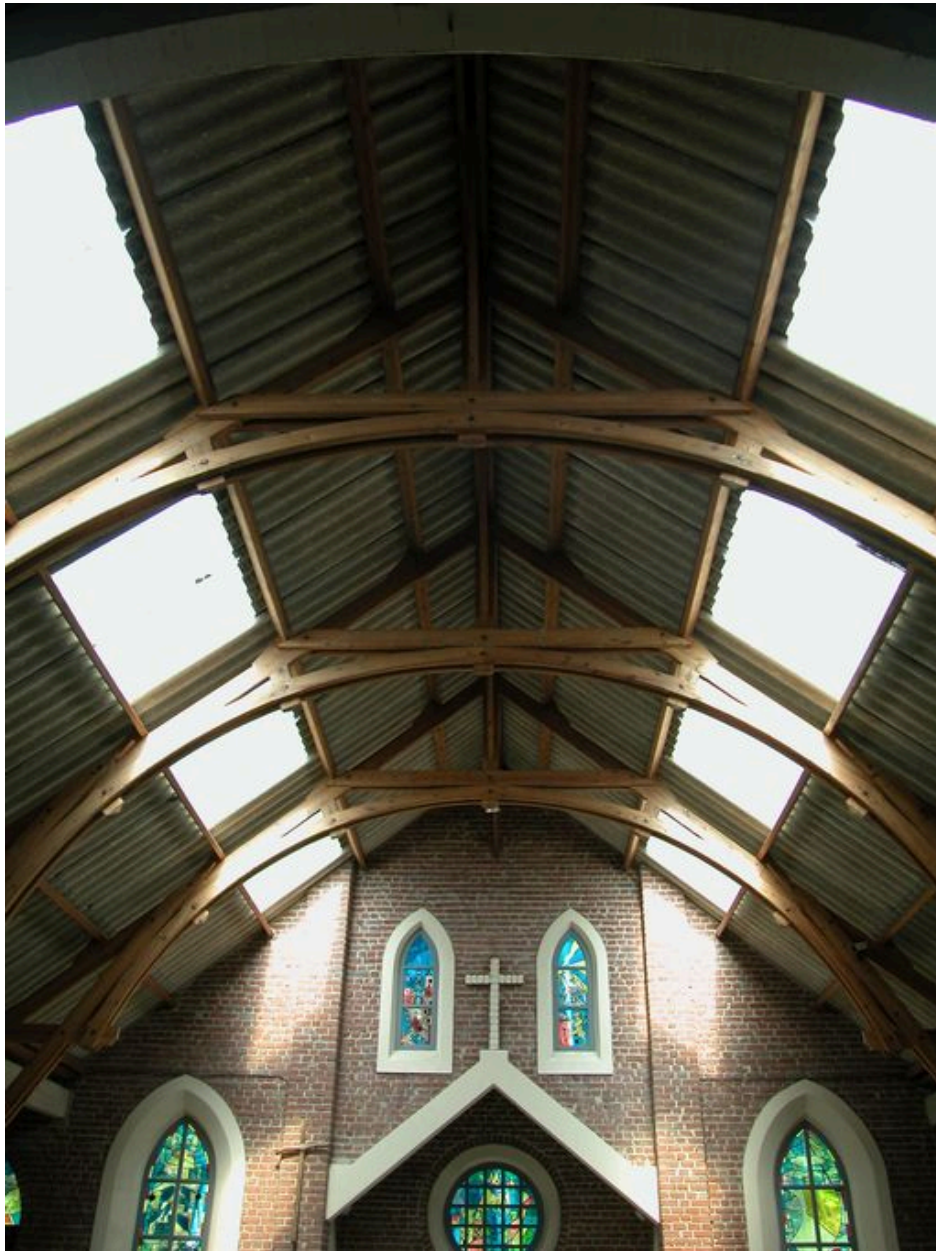
Détail de la charpente.
