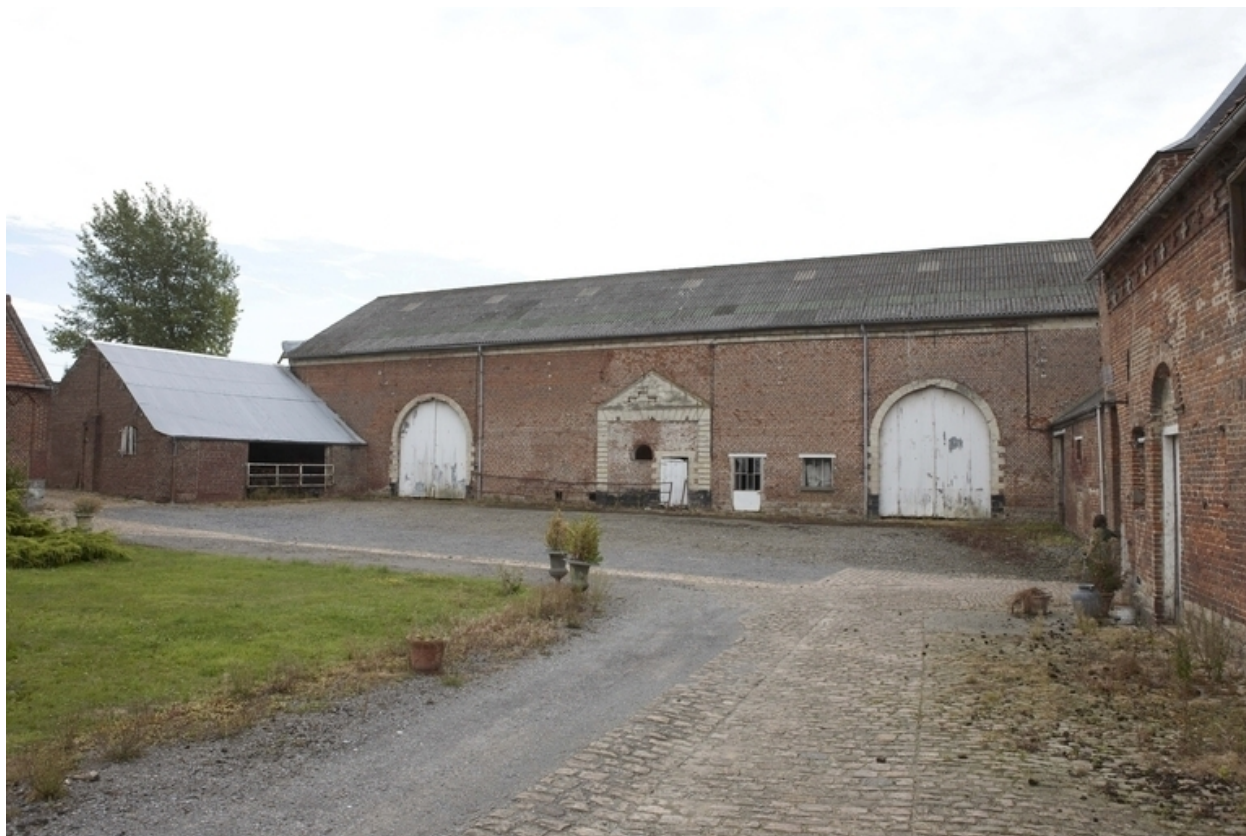
Vue de la grange-étable située au sud.
