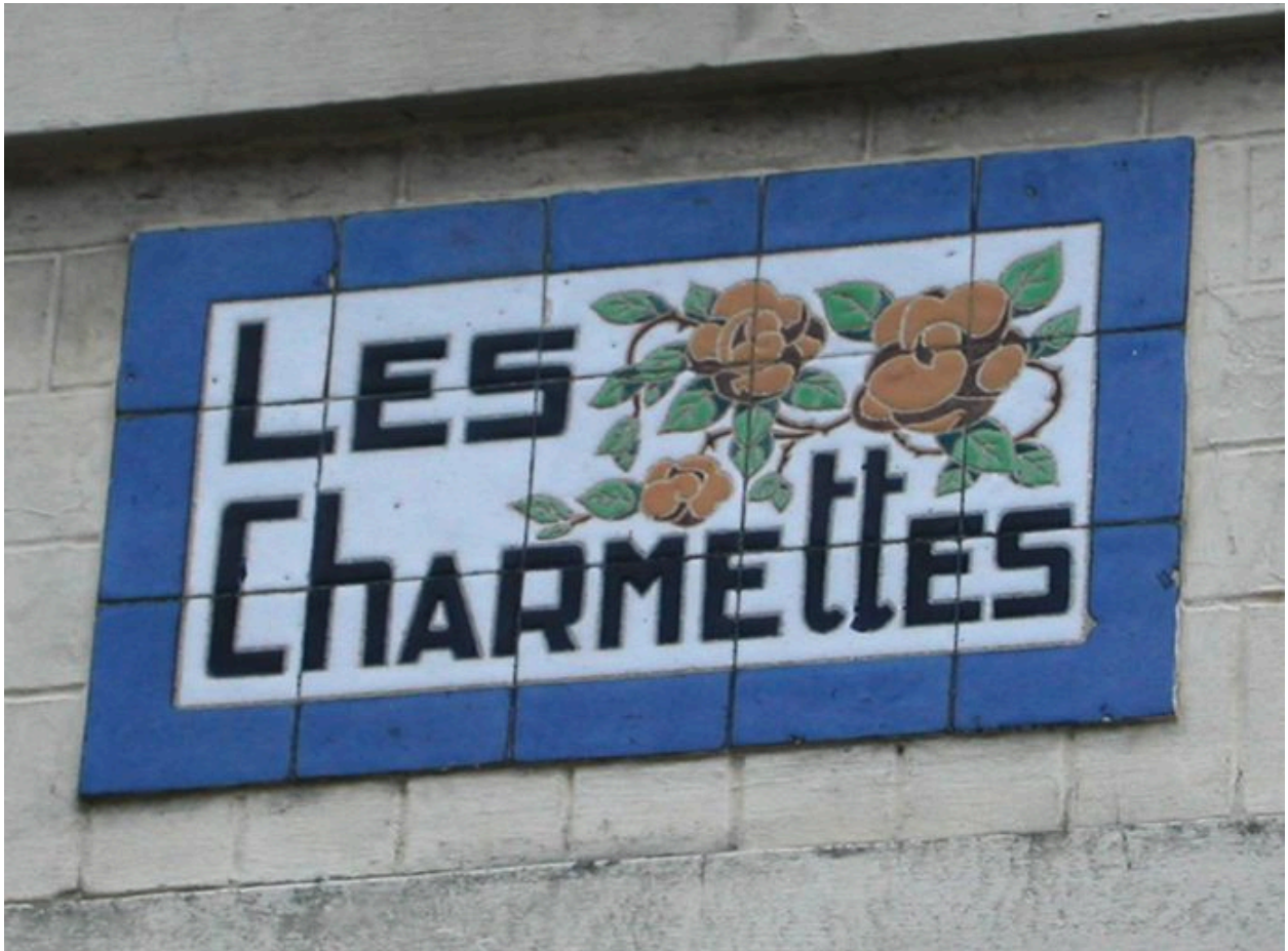
Détail des carreaux de céramique portant appellation de la maison dite Les Charmettes.
