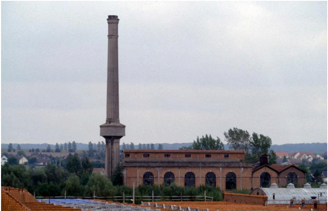
La chaufferie et la cheminée en 1993.
