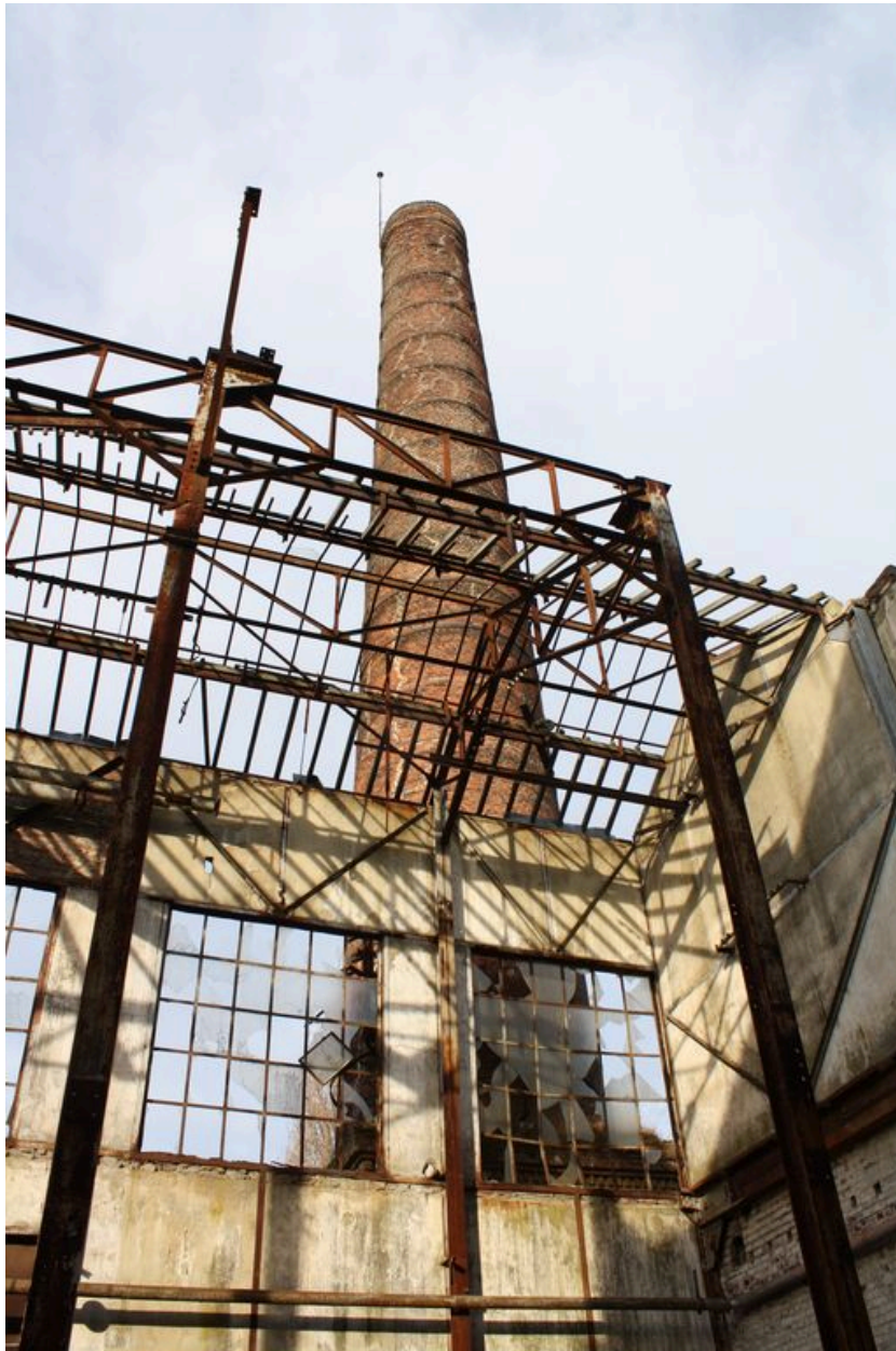
La cheminée et la structure métallique de l'avant halle de fabrication.
