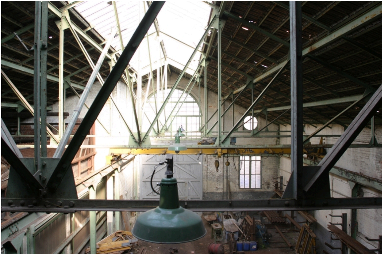
Charpente métallique du magasin industriel.
