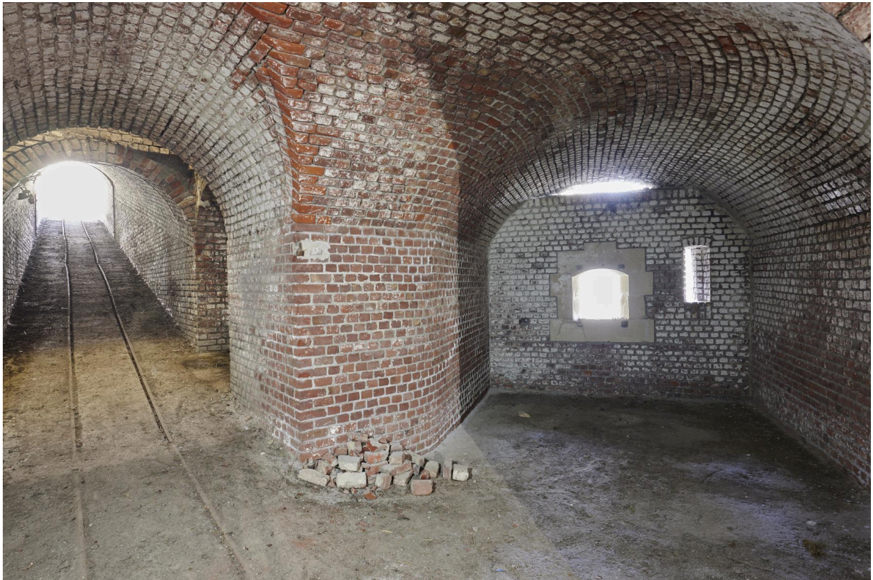
Descente de la caponnière double et chambre de tir.
