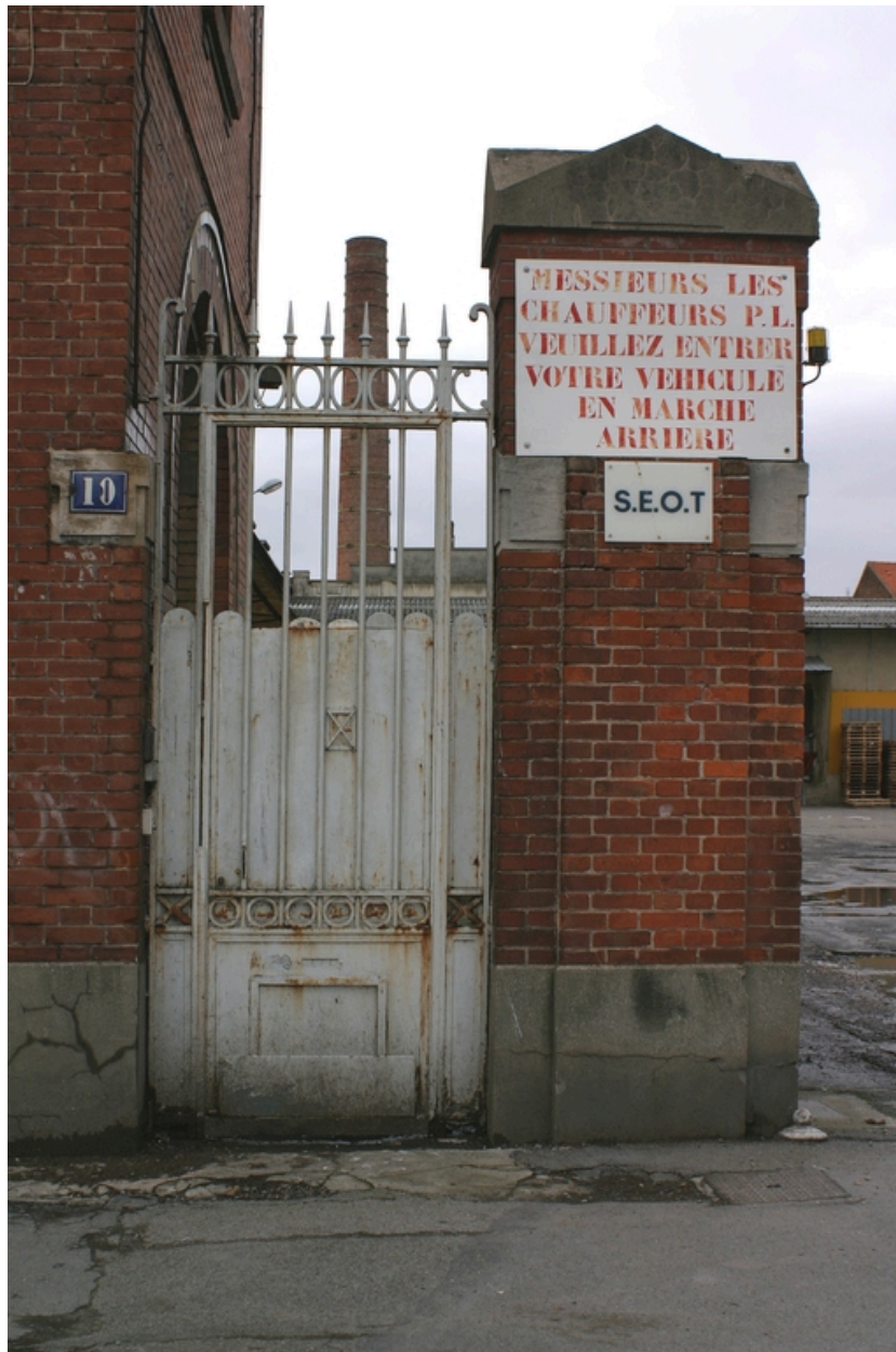
Porte piétonne et cheminée d'usine.
