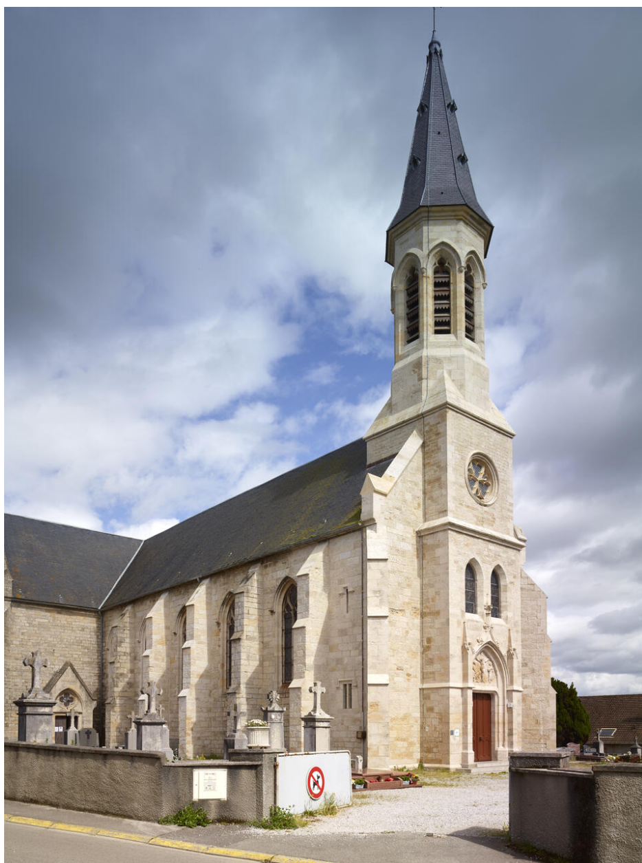
Vue du clocher et de l'élévation nord.
