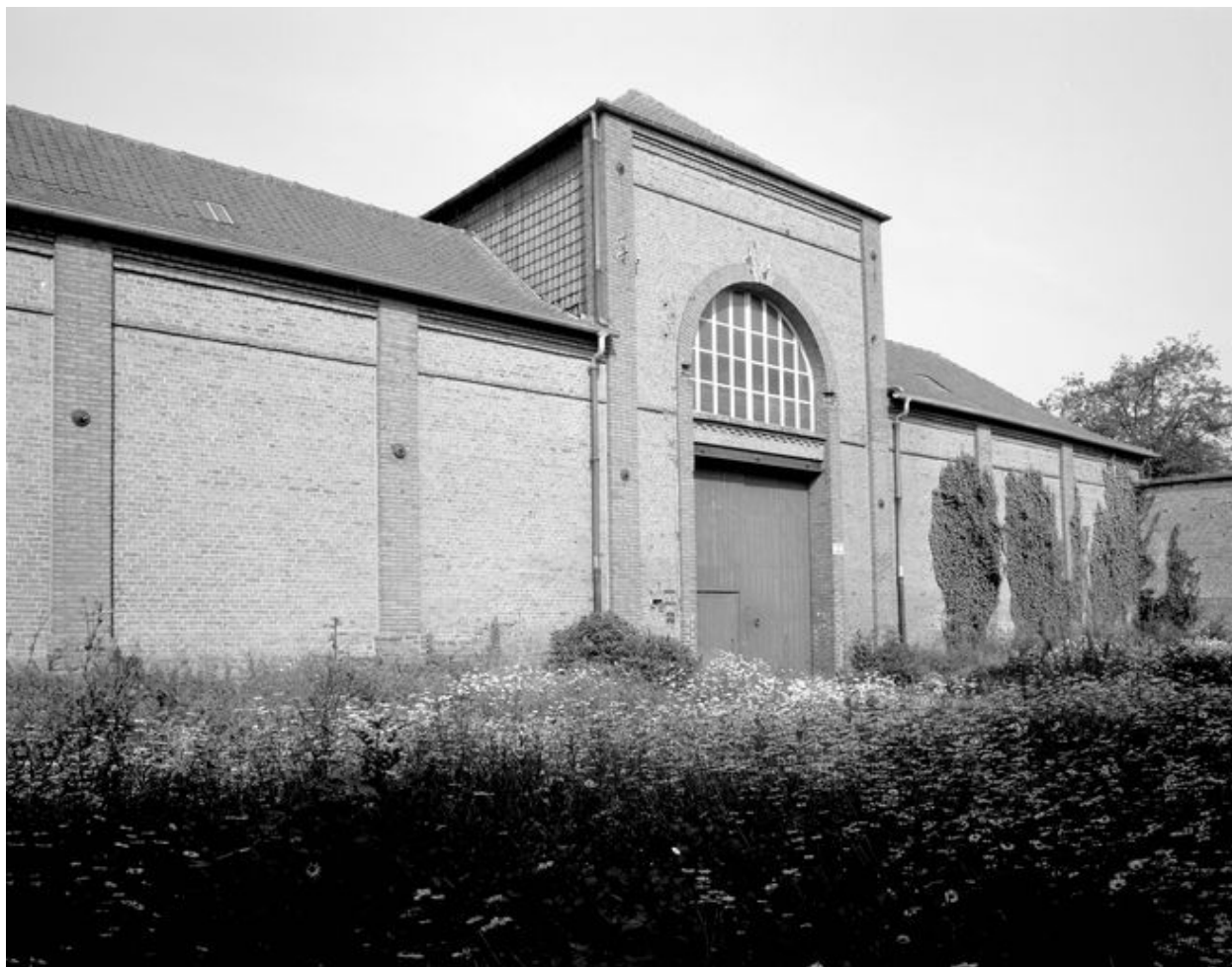
Entrepôt industriel (groupe 1), en 1989 : flanc est.
