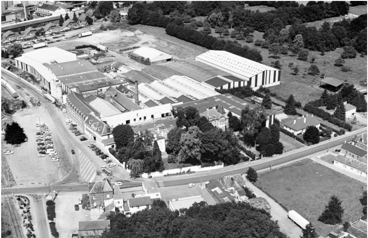
Vue aérienne de la confiserie, vers 1985 avant la destruction des logements patronaux (coll. part.).
