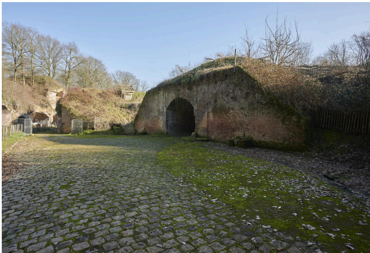
Aile ouest. Vestiges de la crête d'artillerie.
