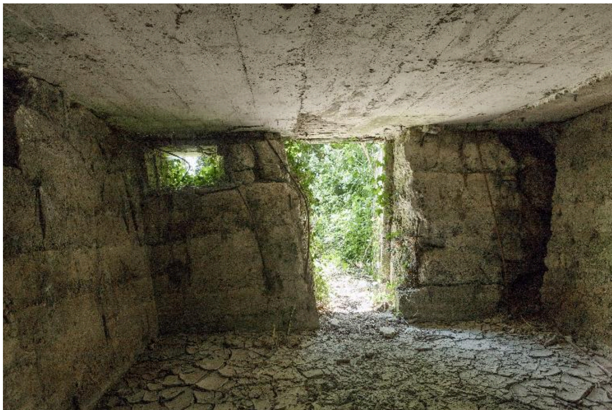
Vue intérieure vers la sortie sud
