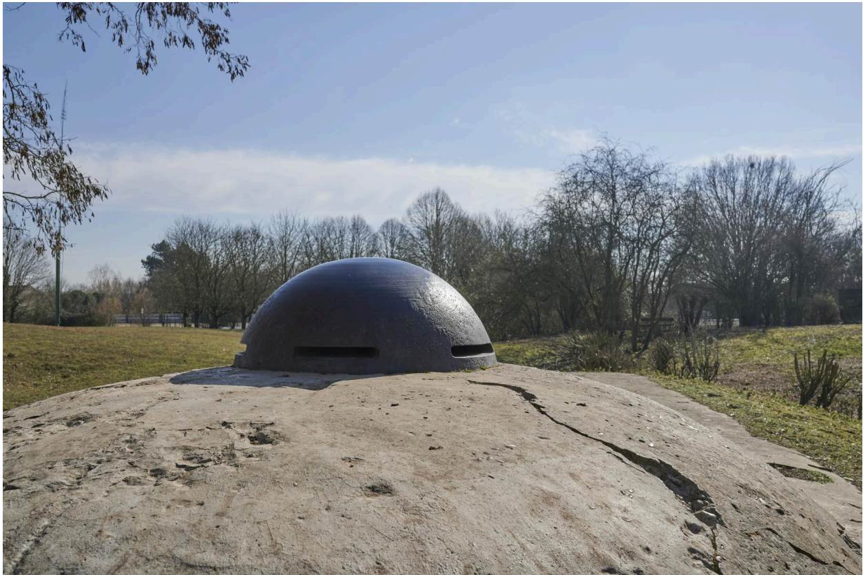
Abri casematé avec observatoire cuirassé. Détail de la coupole vers le sud.
