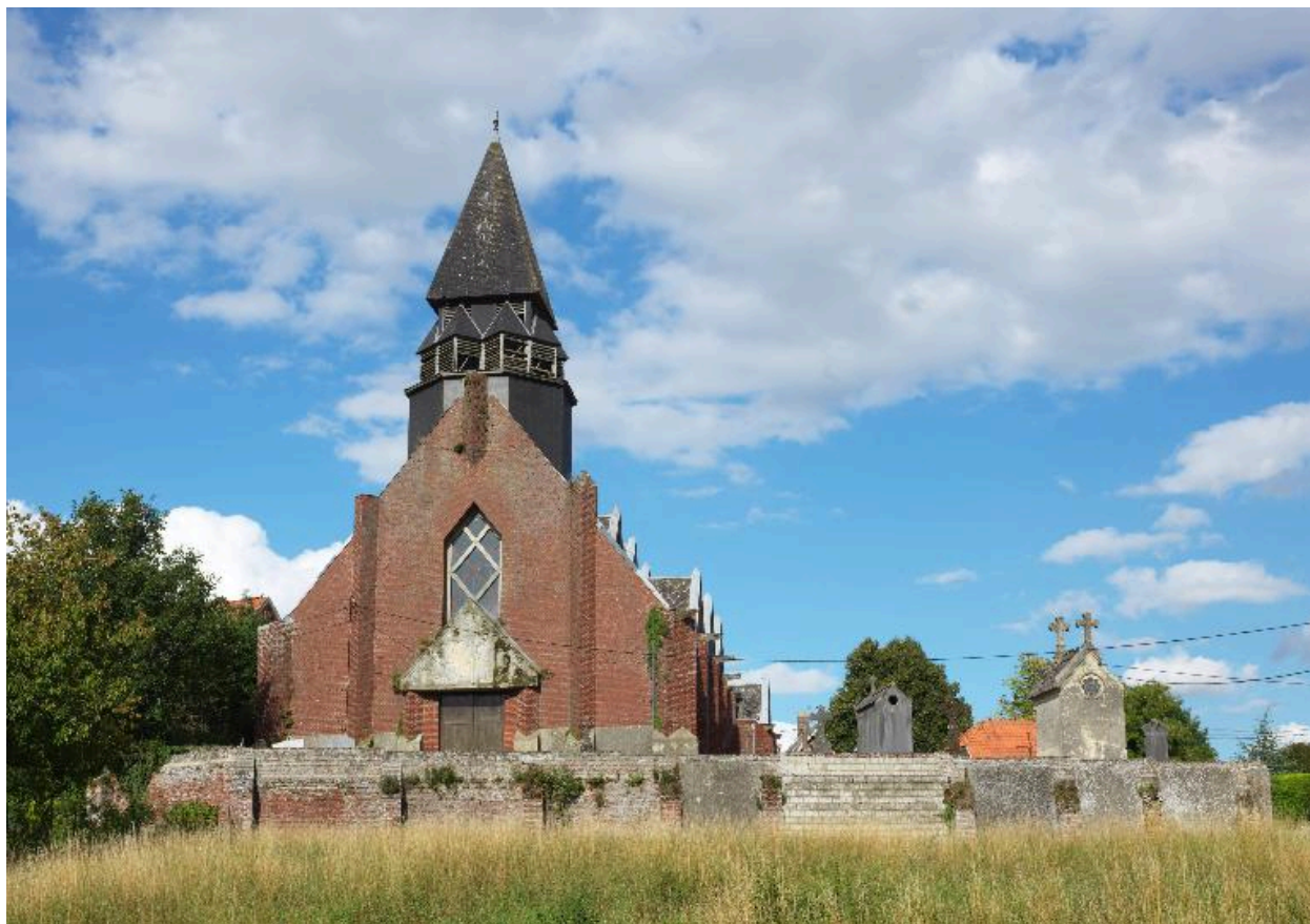
Vue générale de l'église et du cimetière.
