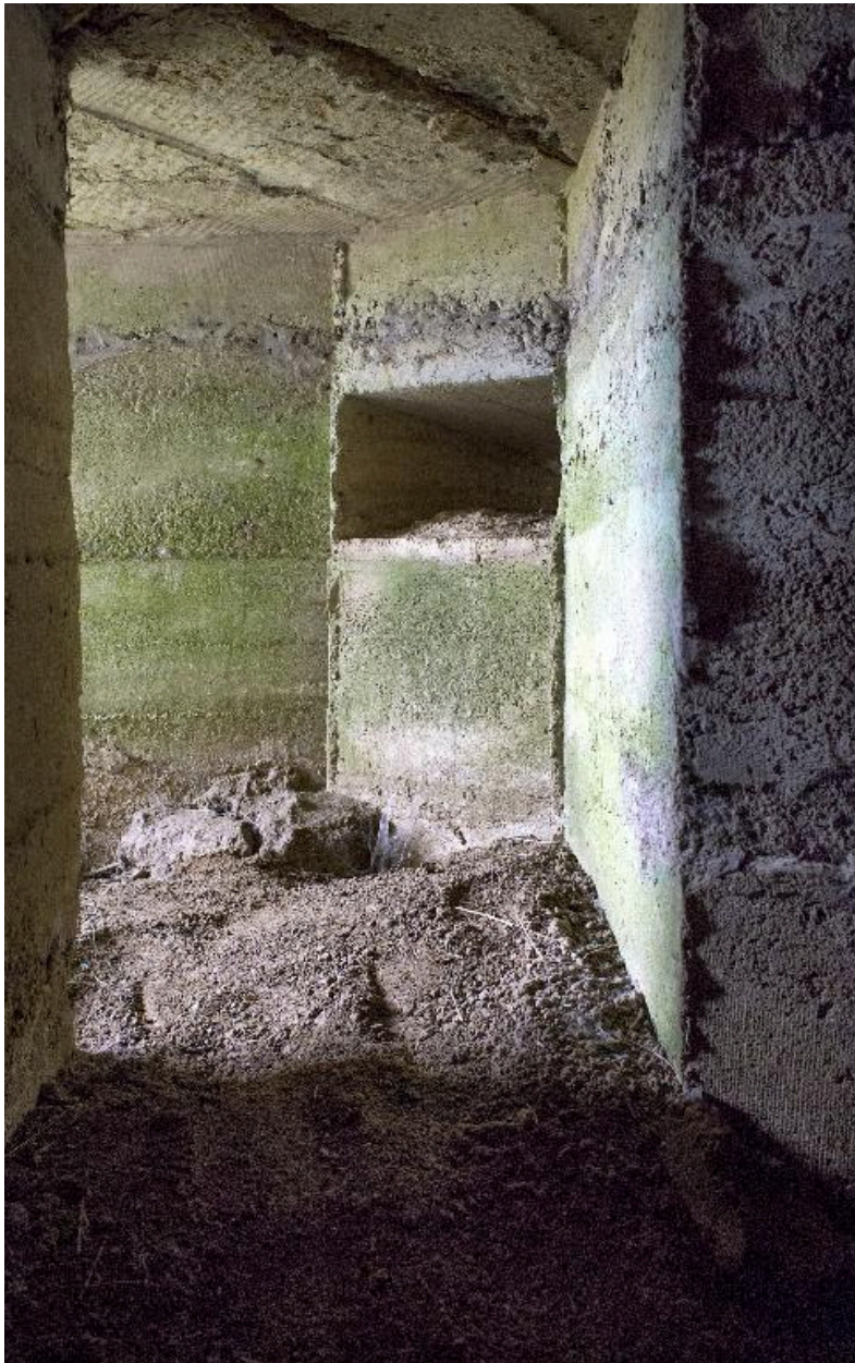
Vue intérieure de la chicane de l'entrée antérieure avec son créneau de fusillade
