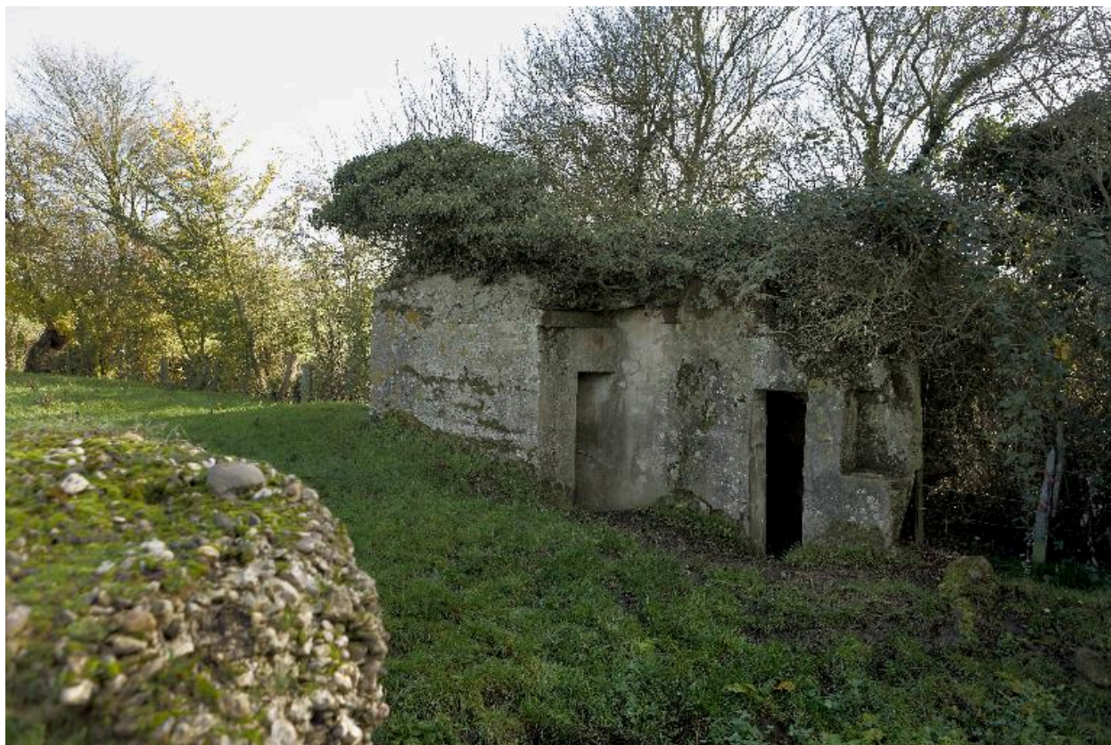
Vue de trois-quarts, vers le sud-est
