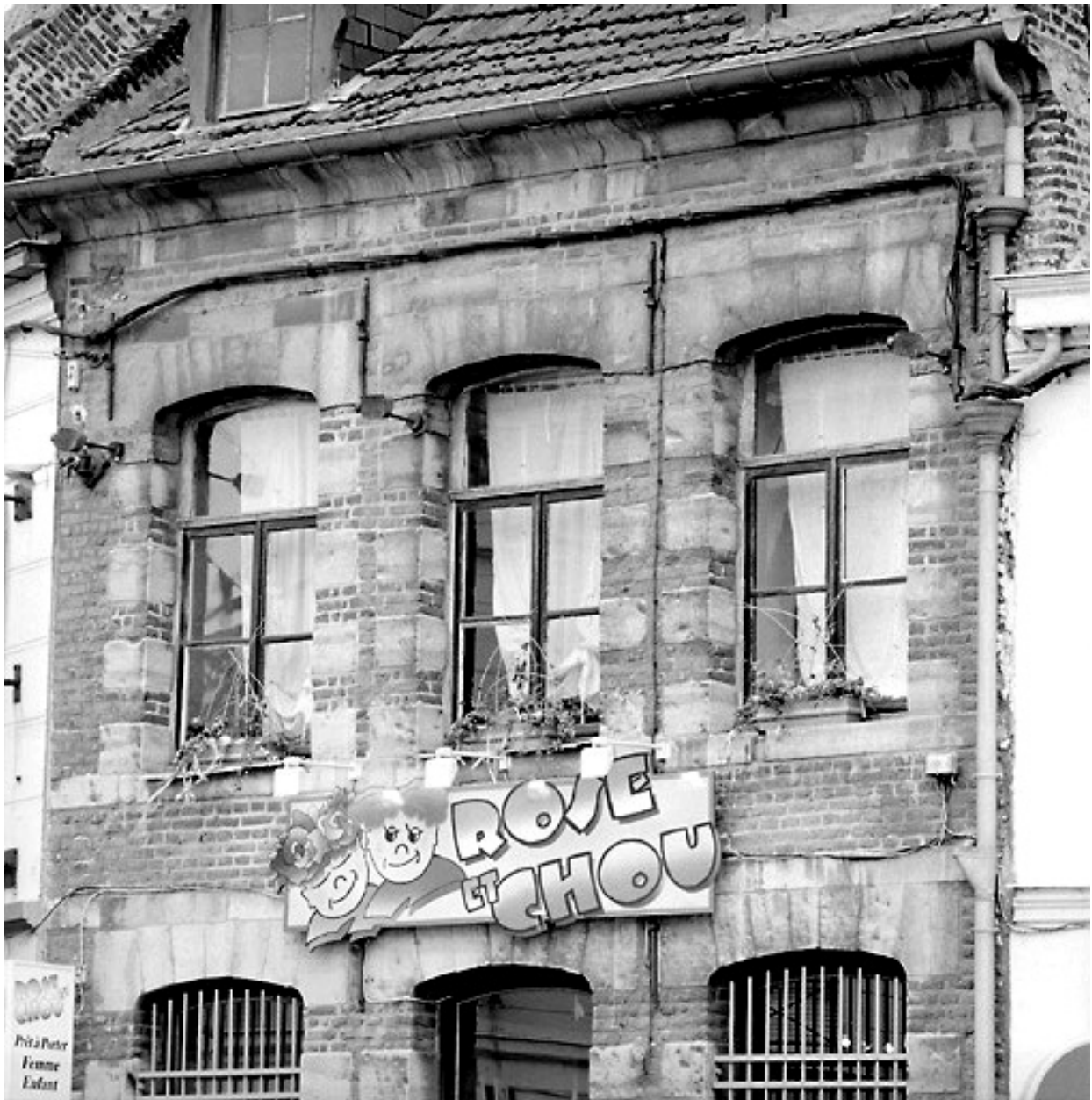
Façade, vue partielle : étage.
