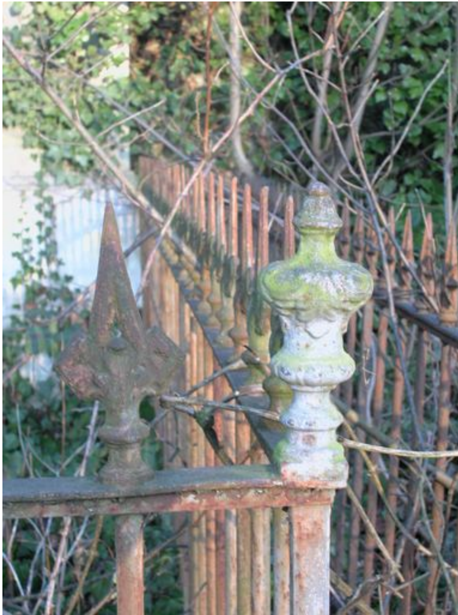
Vue de la grille. Détail de l'ornementation d'angle.
