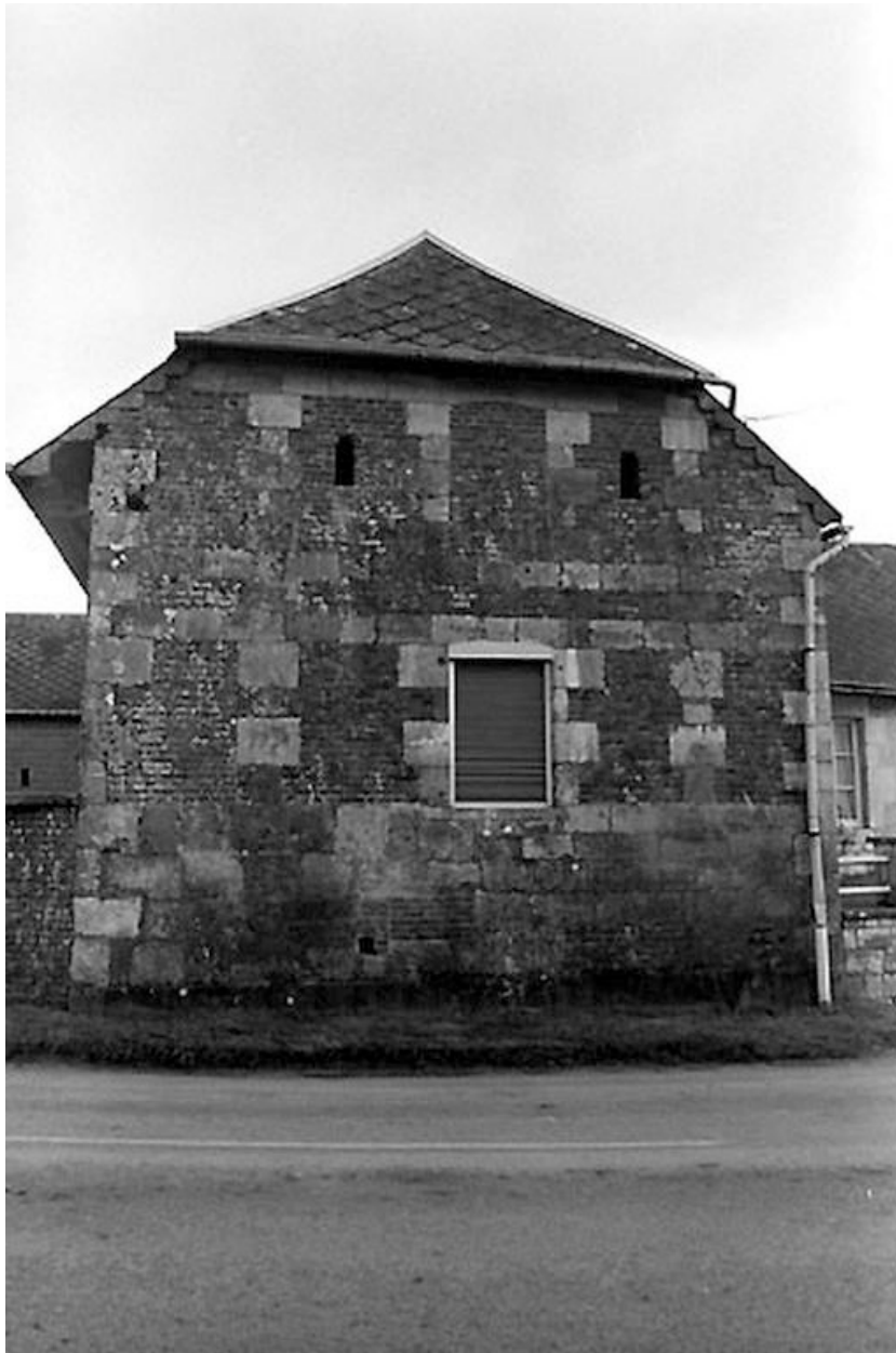
Mur pignon sud de l'aile en retour du logis.
