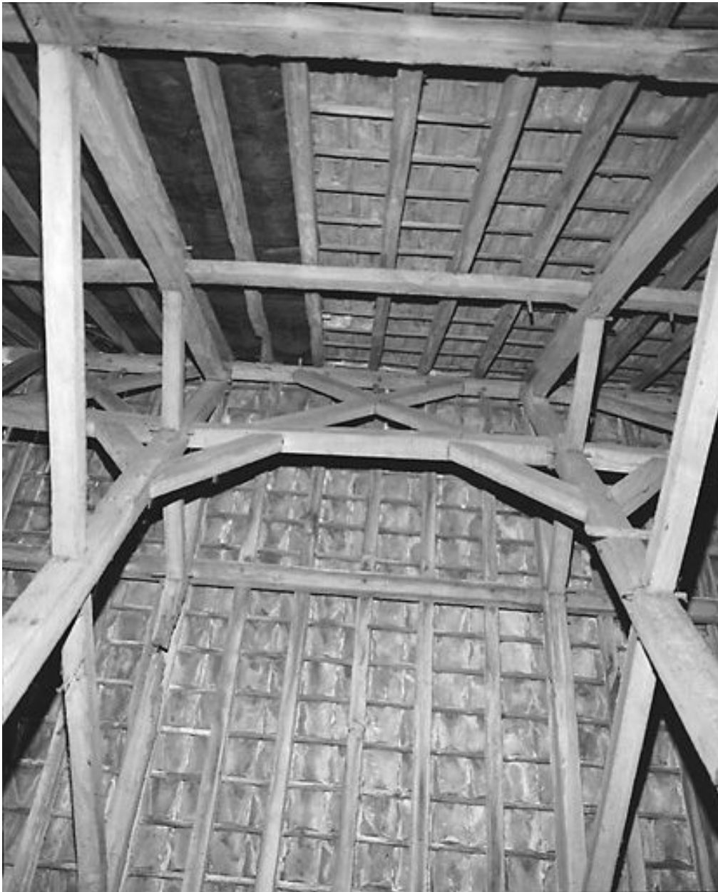
Intérieur, étage de comble : charpente, vue d'une travée entre deux fermes.
