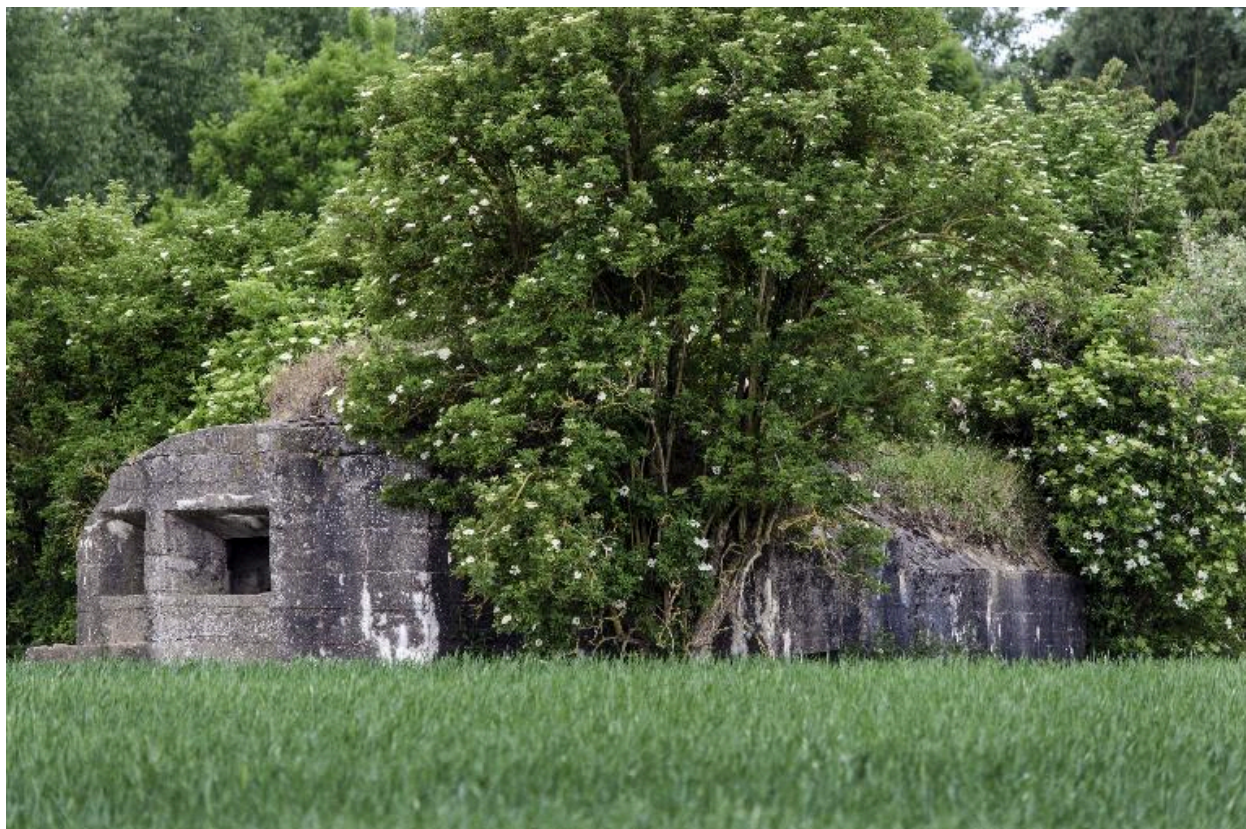
Vue générale vers le sud-ouest
