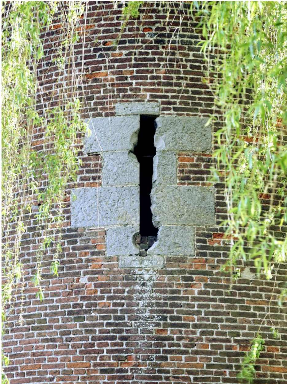
Vue extérieure de l'ouverture de tir nord-ouest (niveau inférieur).
