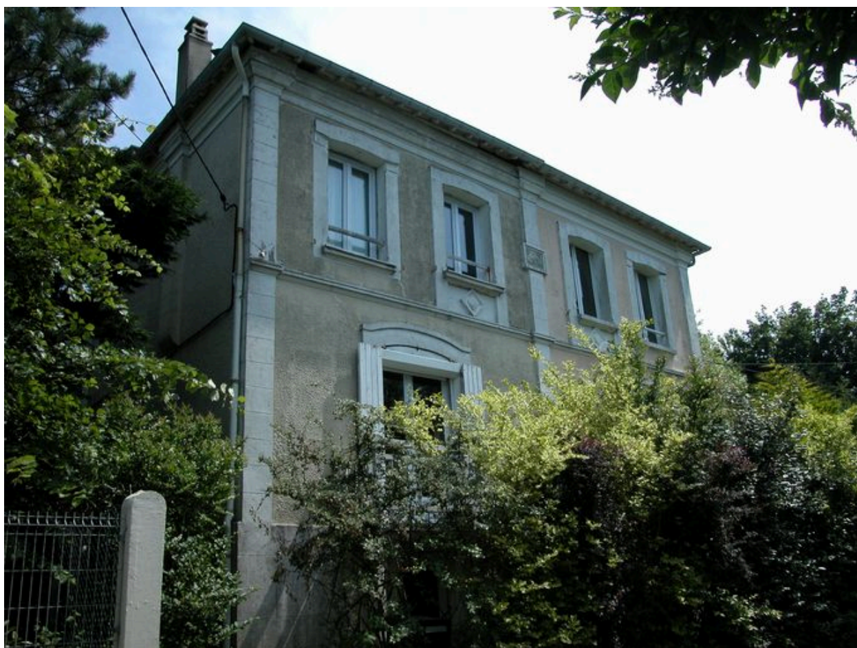
Vue de trois-quarts, façades sud et ouest.
