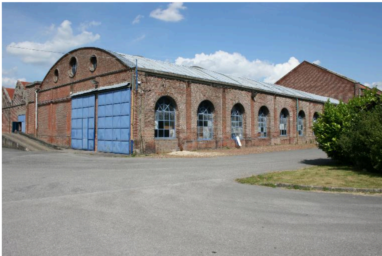
Vue d'ensemble extérieure de l'atelier de pliage.
