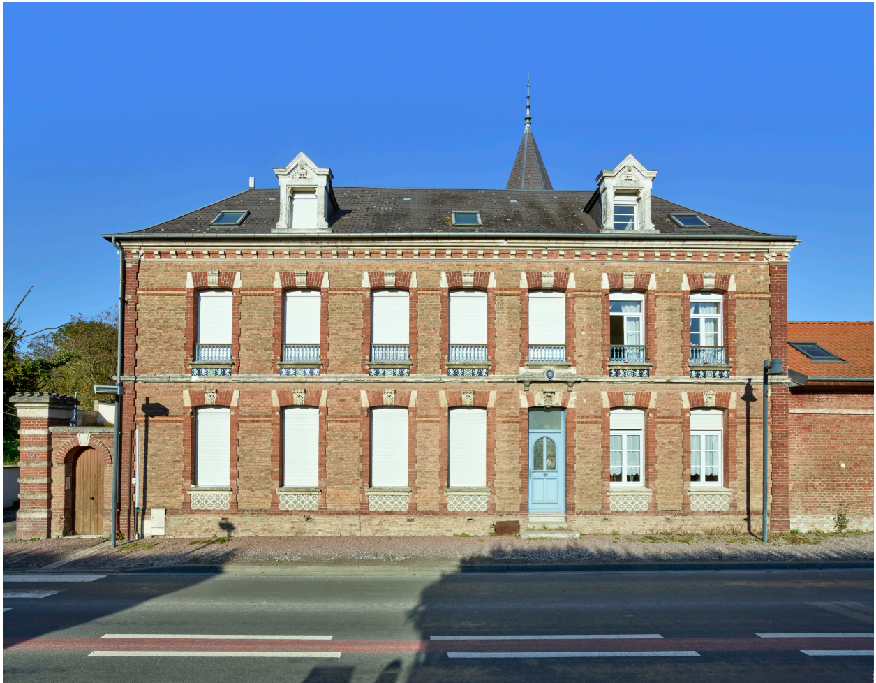
Vue de l'élévation sud, depuis la rue.
