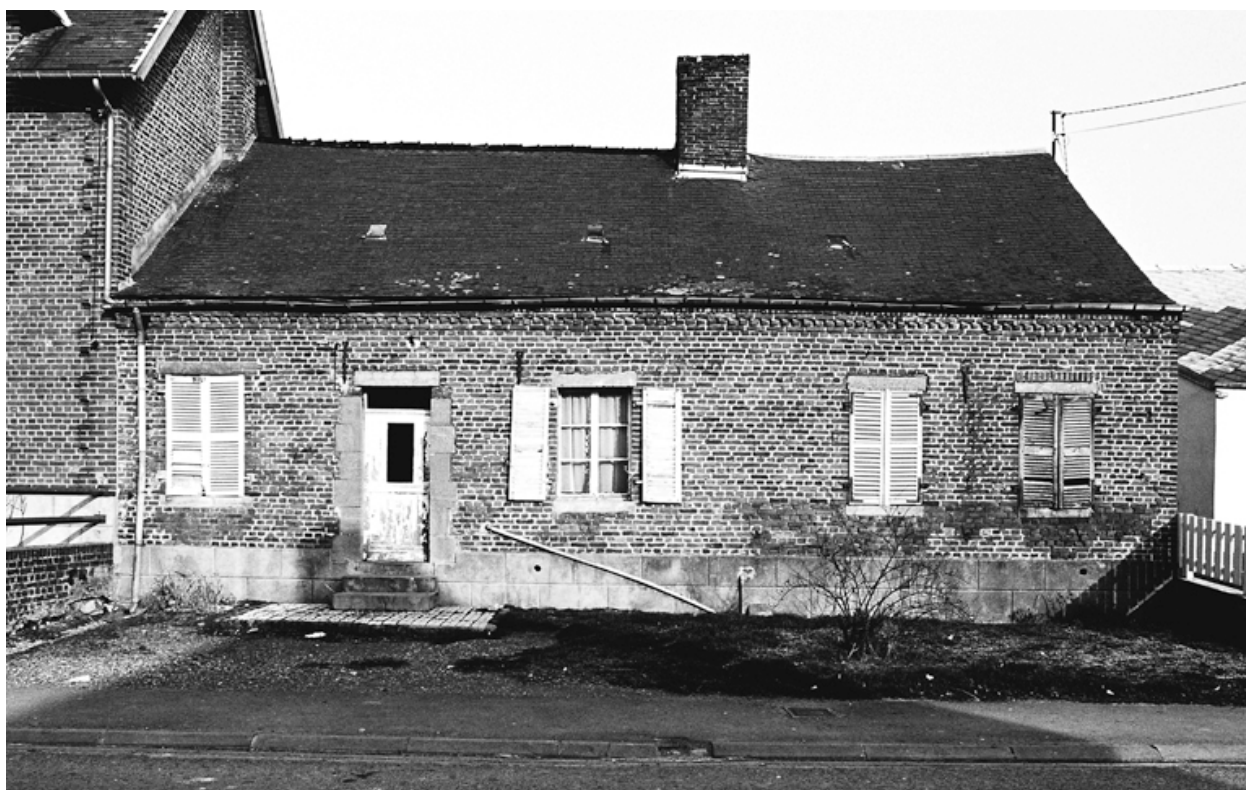
Maison, 22 rue de Verdun.
