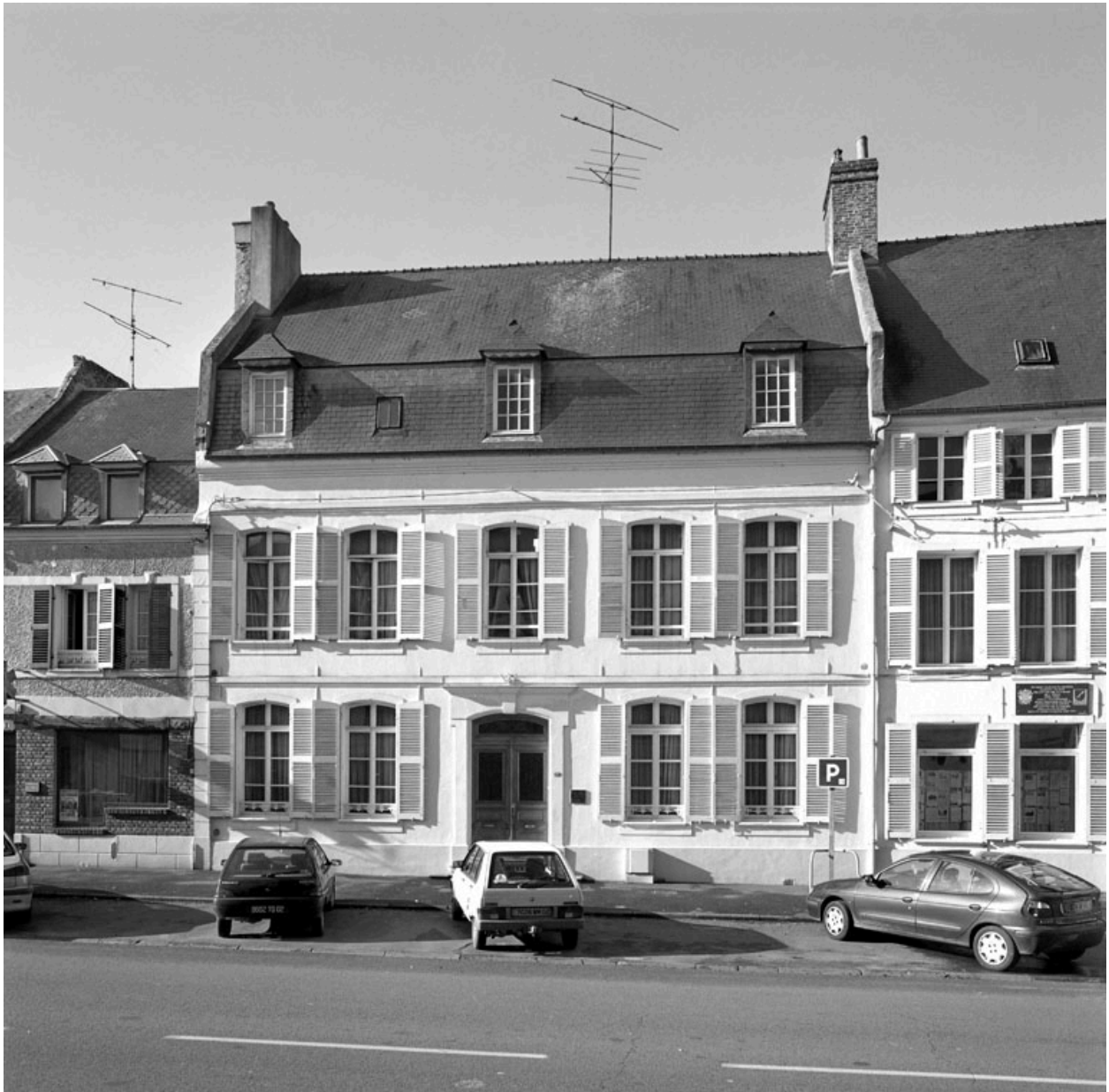
Vue de la façade sur rue du principal corps de logis.
