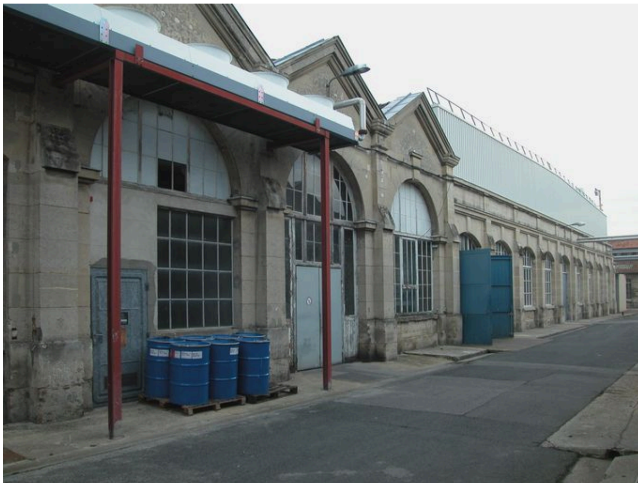
Vue partielle des ateliers de fabrication.
