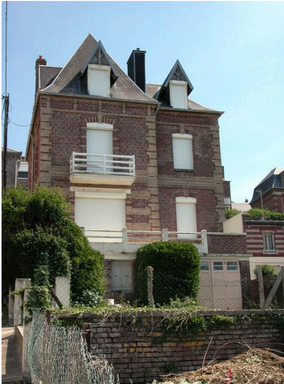
Elévation postérieure, orientée vers la mer.
