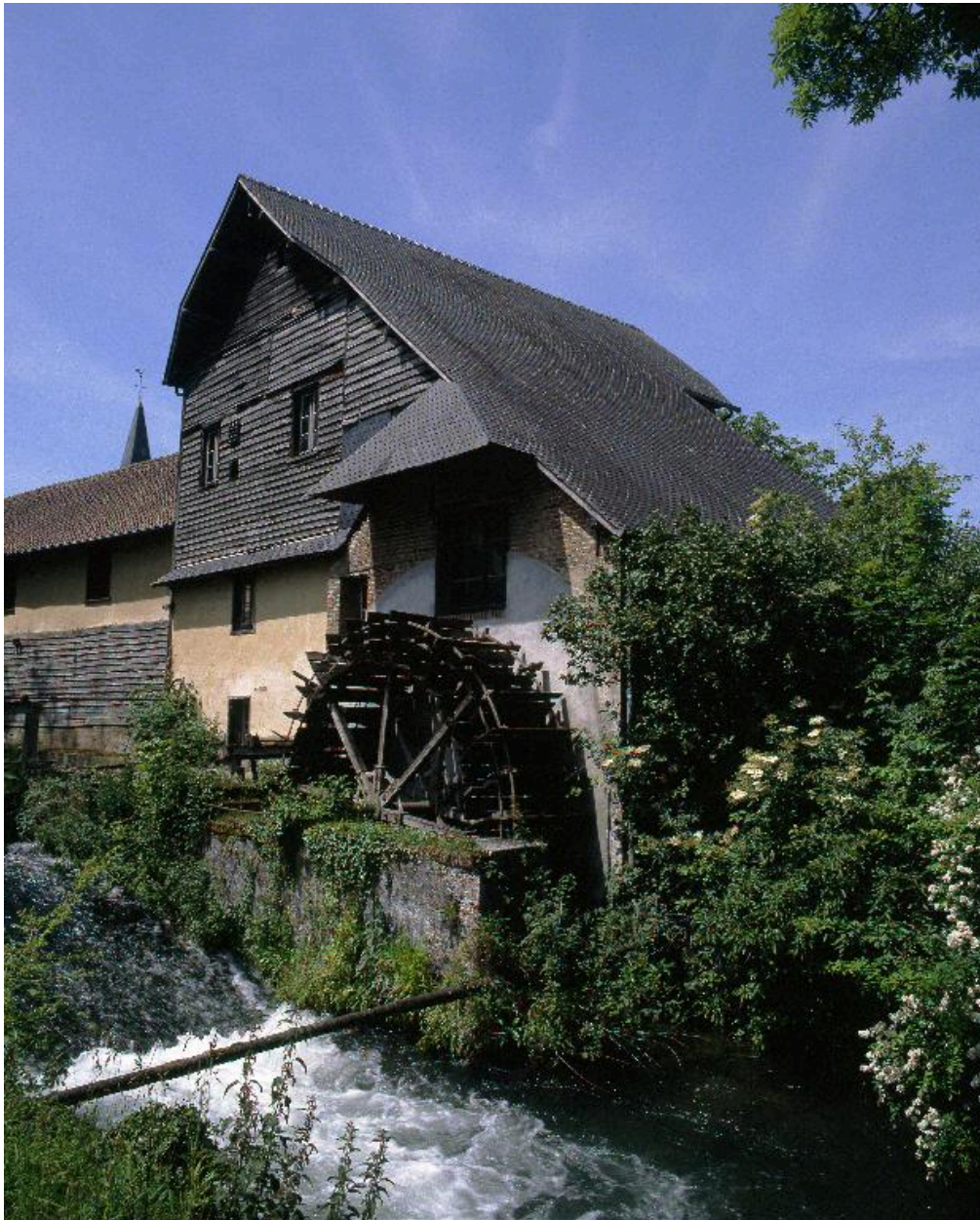
Vue du moulin, depuis le sud-est.
