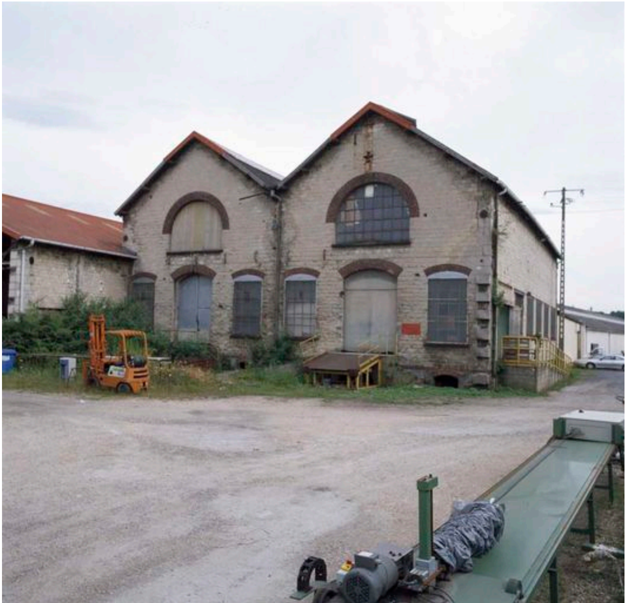
Bâtiment abritant les fours.
