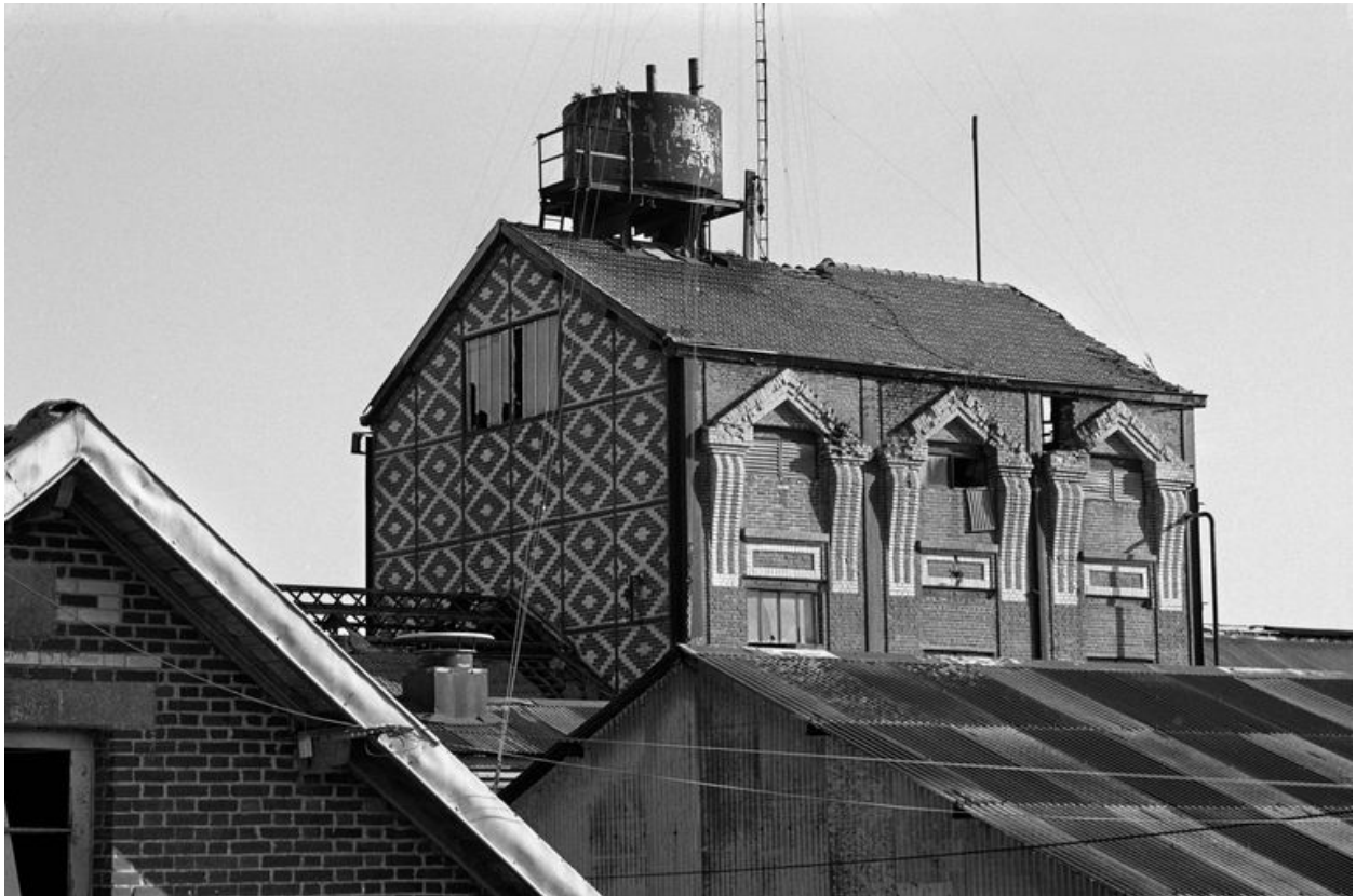
Atelier de fabrication principal : flanc nord-ouest.
