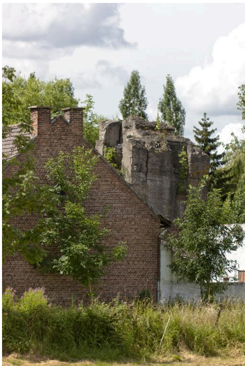
vue générale vers vers le sud
