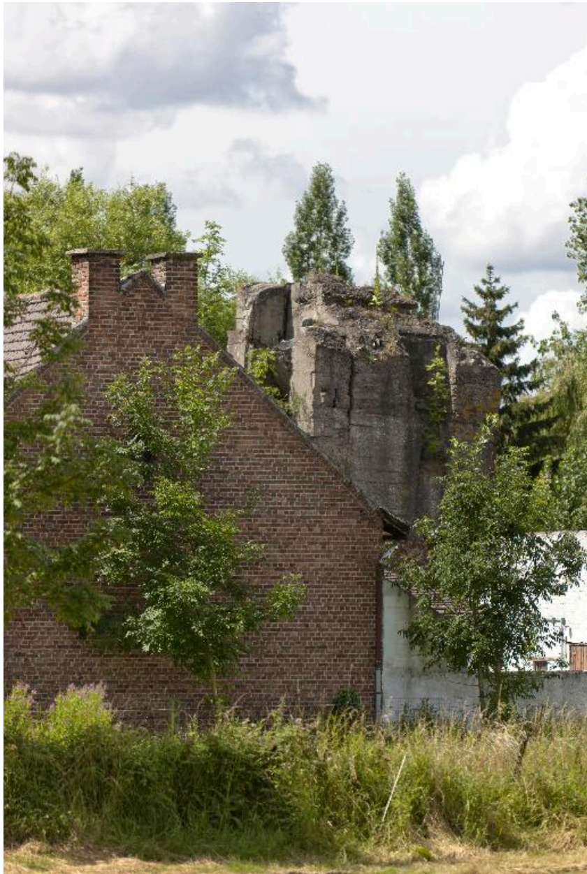
vue générale vers vers le sud
