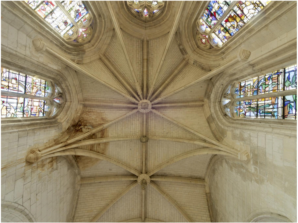
Voûte du chœur.
