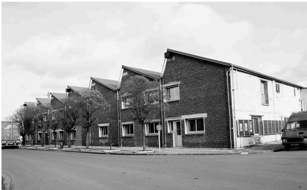
Ateliers de fabrication avec sheds construits vers 1925.
