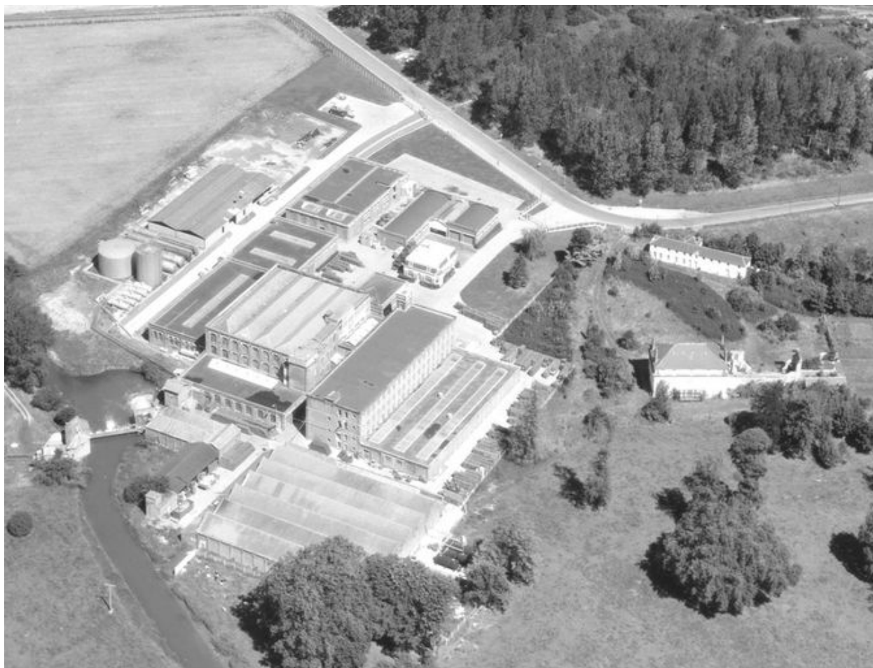
Vue aérienne, vue du flanc sud-est.
