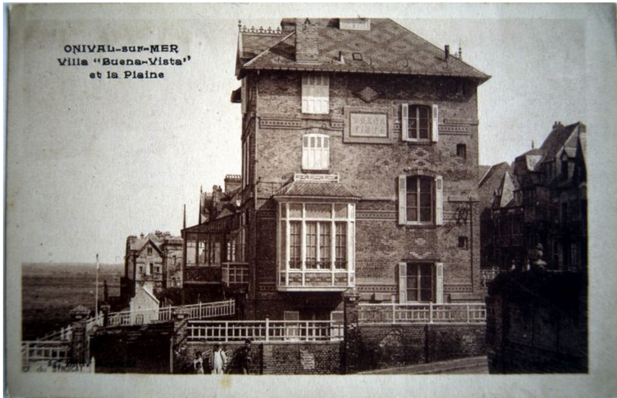
La villa Buena-Vista, rue de la Plage, détruite, carte postale, 2e quart 20e siècle (coll. part.).
