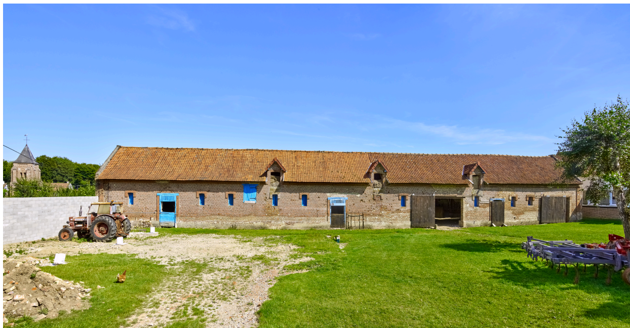
Vue des étables, depuis l'ouest.
