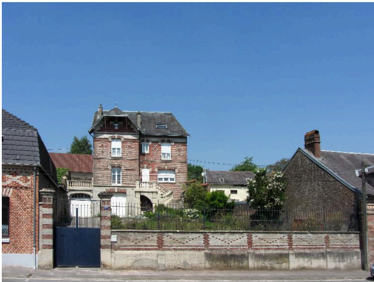
Vue d'ensemble de la propriété depuis la rue.
