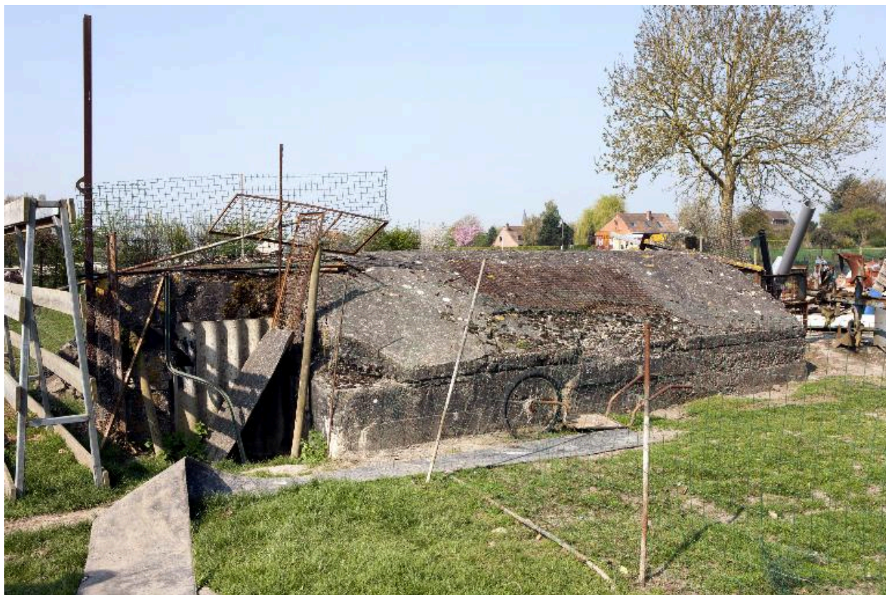
Casemate est, vers l'ouest
