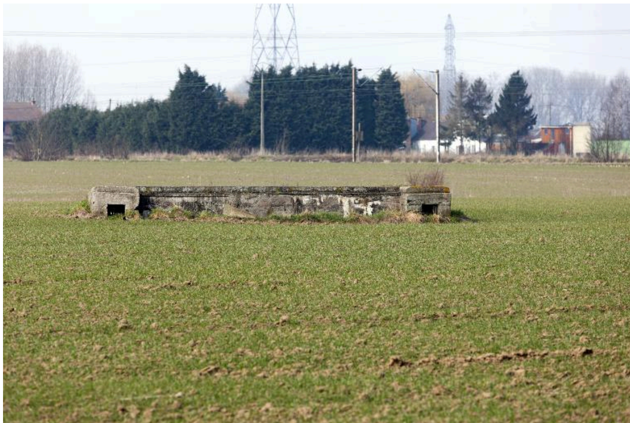
Ouvrage en U, vers l'ouest
