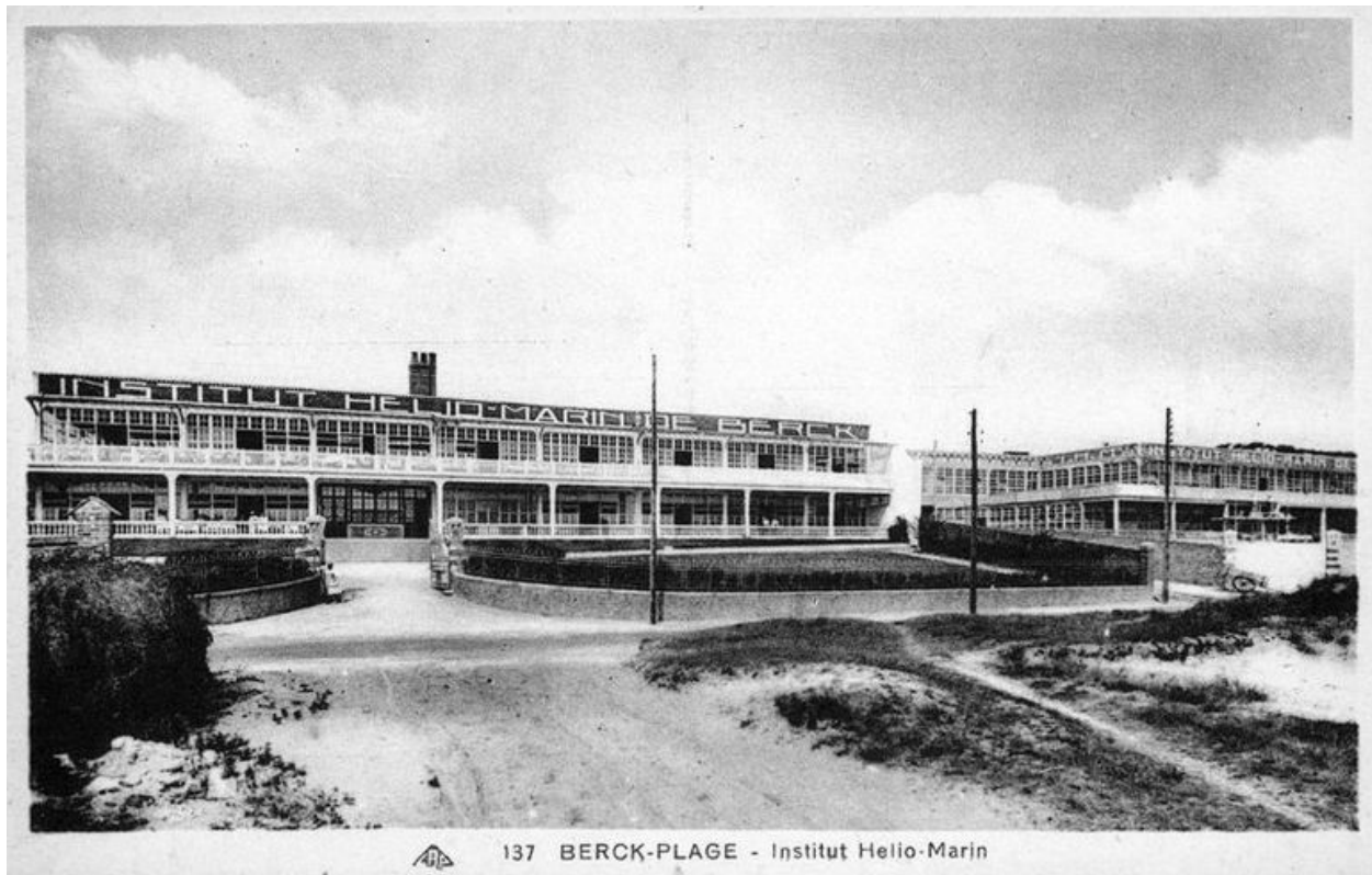
Bâtiments A, à gauche, et B, à droite, élévations antérieures, vue d'ensemble prise de trois-quarts gauche. Carte postale, 2e quart du 20e siècle.
