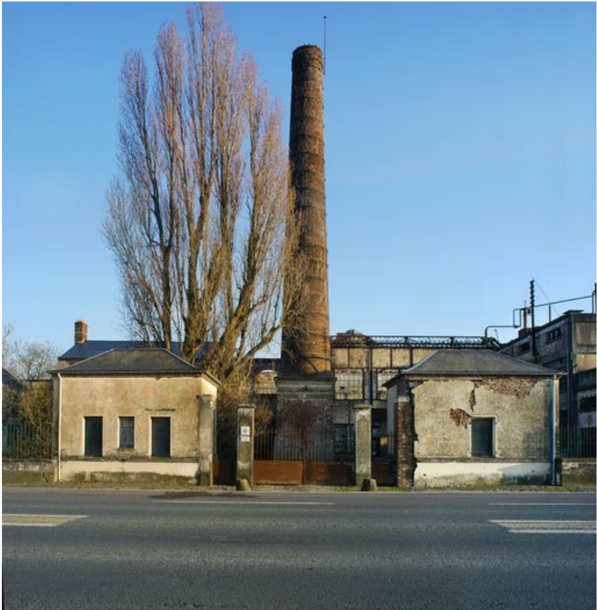
Les pavillons d'entrée à usage de conciergerie et la cheminée au milieu de la cour d'honneur, vue d'ensemble depuis l'ouest.
