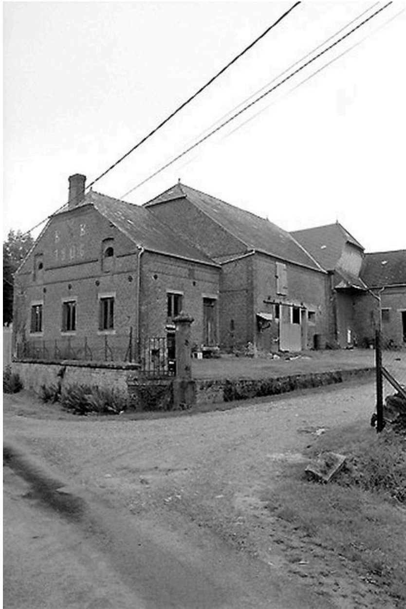
Grange et logement attenant portant la date 1906 et les initiales du propriétaire Rendu-Bissex.
