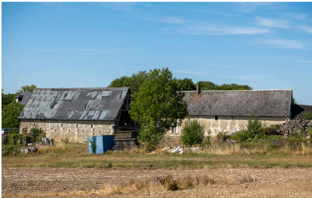
Bâtiments de l'ancienne ferme seigneuriale, vue depuis la rue du Plessier-sur-Bulles.
