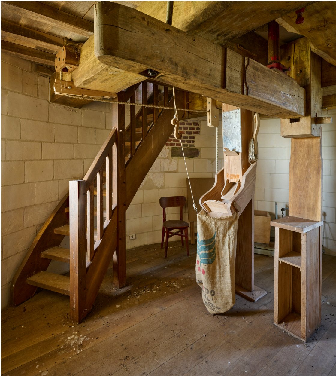
Intérieur, premier étage du moulin.
