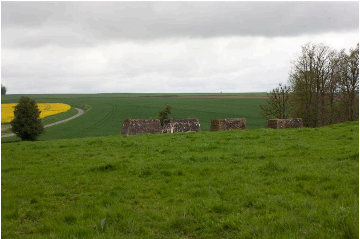
Plots de la rampe de lancement.
