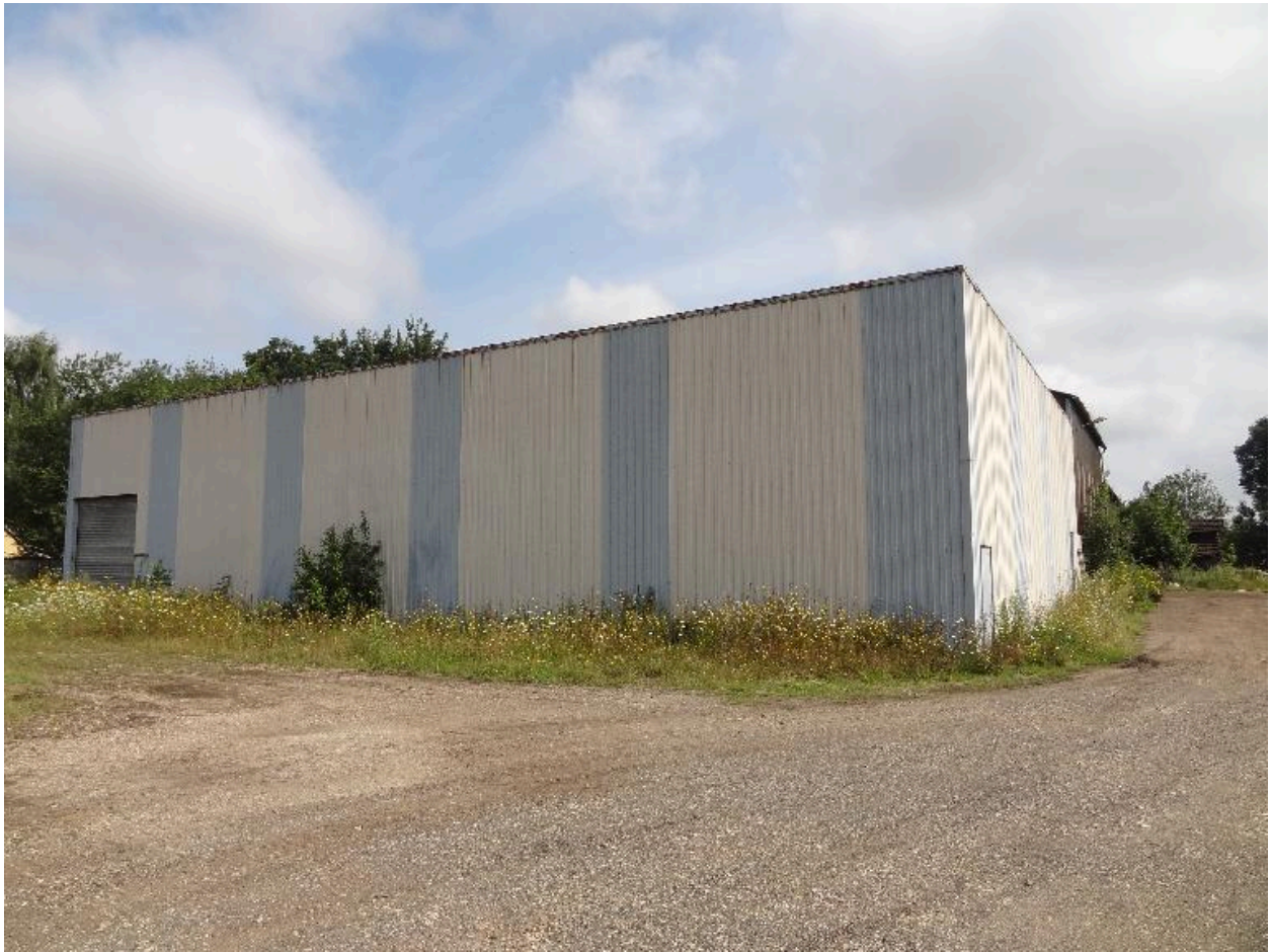
Ancien atelier de stockage.
